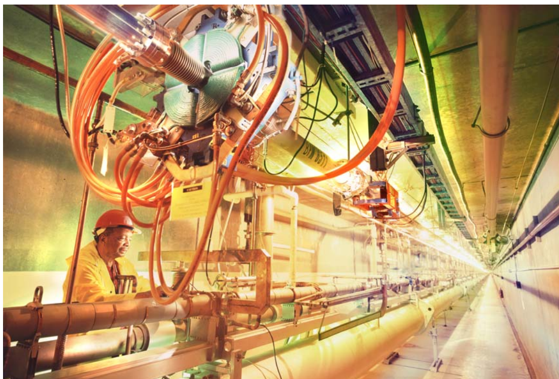
Figur 8. Den 5 km lange SLAC accelerator ved Stanford, Californien. Øverst ses en kvadrupol-magnet. Ved at skyde elektroner fra denne accelerator ind i protoner, så man for første gang en “grynet struktur” i protonen. (SLAC).
